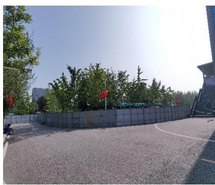
隔离区围挡施工
